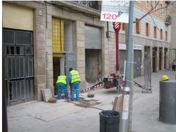
FOTO 1. Vista general de la intervenció arqueològica en el número 51 de la Rambla del Raval
